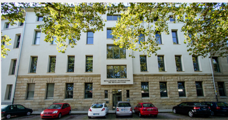
Bild 1: Außenansicht des IME
